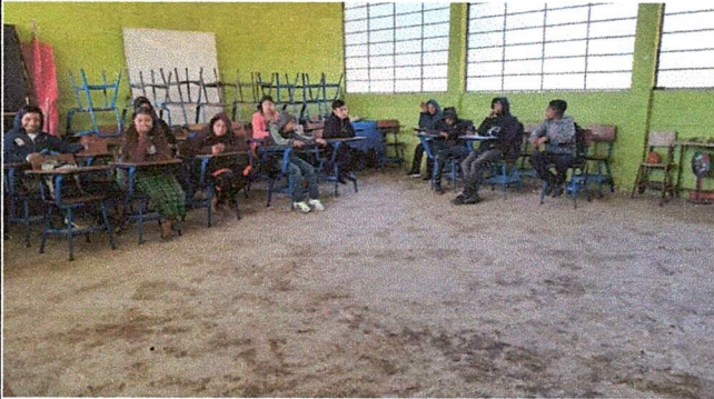
Foto 1: Mejoramiento de piso
