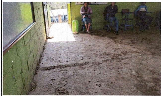
Foto 2: Mejoramiento de piso
